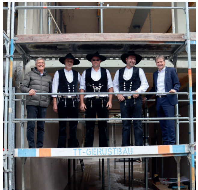
Schulleiter Dr. Roland Plehn, Zimmersleute und Landrat Günther-Martin Pauli sind mit dem Baufortschritten am Schlossberg hochzufrieden
